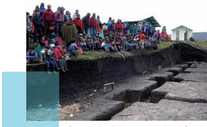
Construcción cimientos escuela Alausí, Ecuador.
