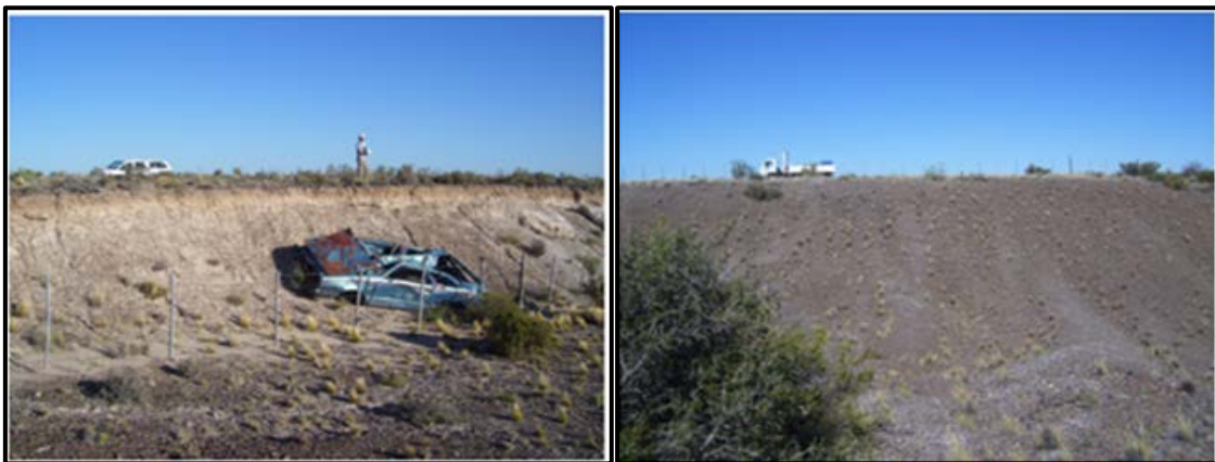
Figura 8. La fotografía izquierda muestra la imagen de un vehículo al pie del talud luego de un accidente vial y en la fotografía derecha se observa la altura del talud excesivamente pronunciado, producto de una extracción de árido cercana a la ruta.
