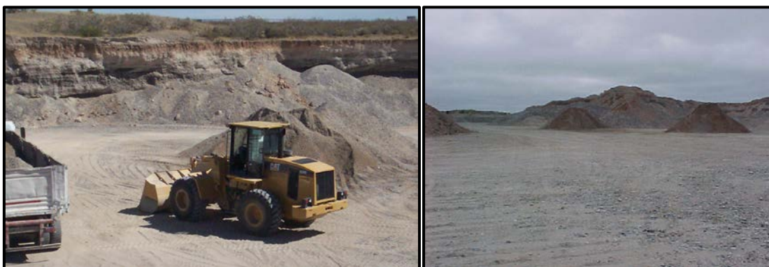
Figura 5. En la fotografía de la izquierda se observa la forma de explotación en el yacimiento y la profundidad de excavación mientras y en la fotografía derecha el estado del terreno posterior a la explotación con pérdida total de cubierta vegetal.
