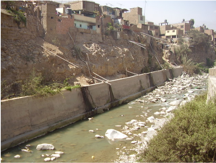
Figura N°2: Contaminación por desagües que van directamente al Río Rímac
